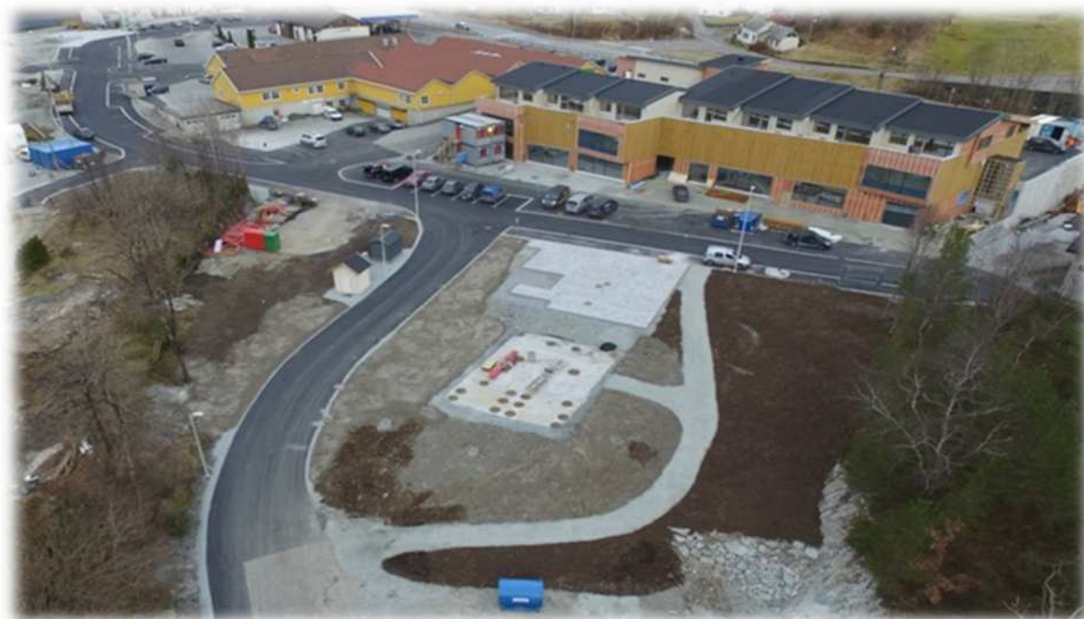
Bjørkheim –VA-anlegget, park og bibliotek – Foto Hylland
