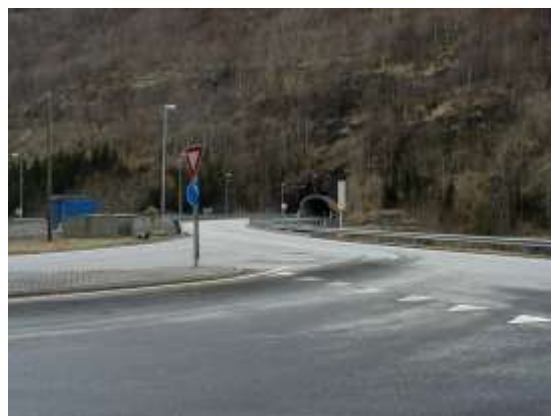
Fig 31: FV48 Frøland- Sævellvegen( fylkesvegen mot Fusa kommune
