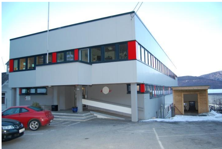
Kommunehuset fekk ny fasade vinteren 2012/2013.
