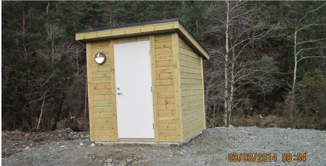
Nytt vassinntak Rolvsvågen
