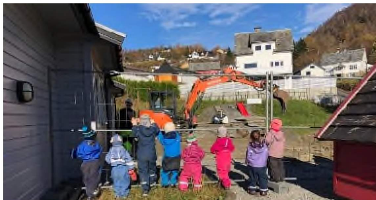
Spanande byggeaktivitet på Dråpeslottet - nytt leikestativ
