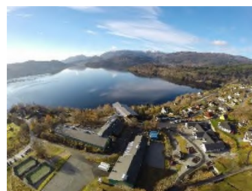
Etter byggjesteget nr.2
