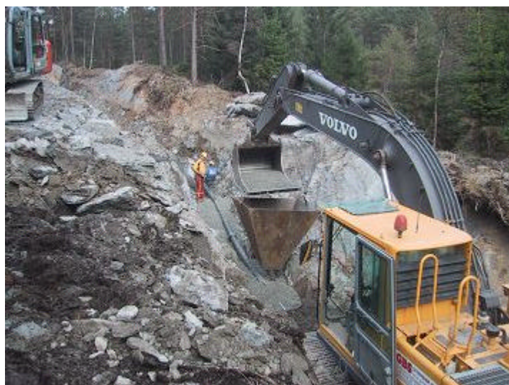
Fråarbeidet med hovudvassverket
